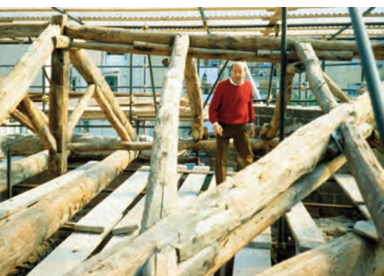
Palermo, aprile 1993, palazzo della Cuba, visita alle strutture lignee della copertura di una porzione dell'edificio. (ph. F.Tomaselli)
