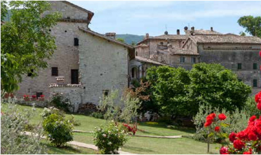
5. Silvignano (Spoleto, Perugia), Villa del Contado, oggi dimora storica Le Logge (XI-XV sec.). Intervento di restauro e recupero funzionale attuato, con grande senso della misura e attenzione al carattere del luogo, tramite la conservazione materiale, anche delle antiche superfici in pietra a vista e intonacate, e la cura della vegetazione. Esso ha prodotto positive ricadute sull'intero borgo (concorso FICLU 2016).
